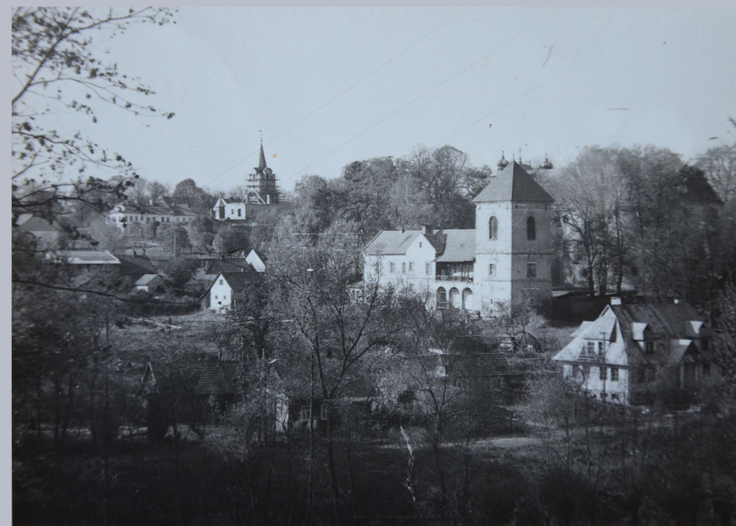
Widok dzwonnicy i plebani w Nowym Wisniczu. W tle remontowana wieża ratuszowa w latach 1985 -1995. Fot. arch. U. Śliwińska.
