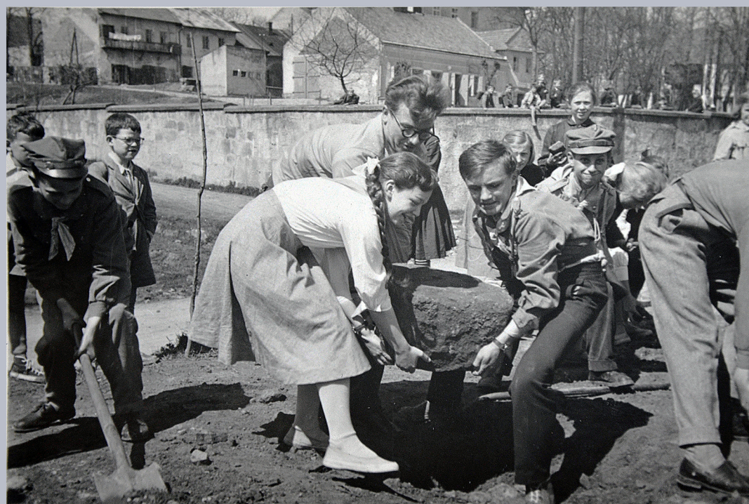
Czyn społeczny - porządkowanie placu przed szkołą podstawową. Ponad murem okalającym rynek widoczny budynek remizy strażackiej. (Fot. 1959r.). Fot. arch. B. Klasa.
