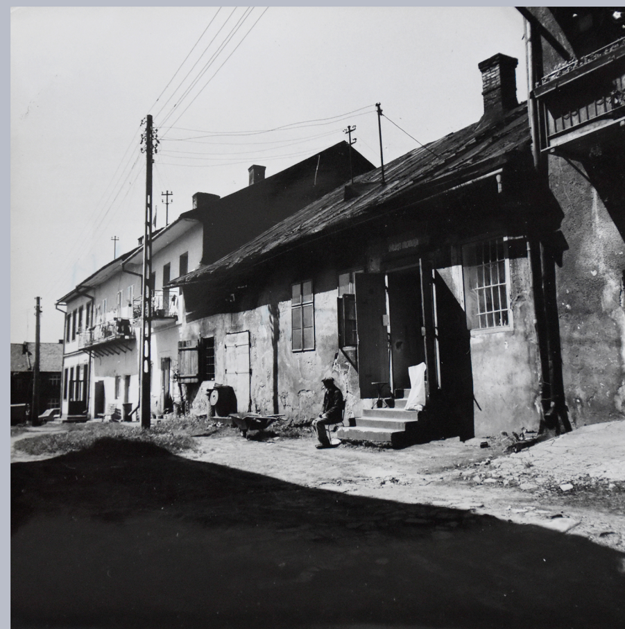
Zabudowa wiśnickiego ryнку - widok od strony ratusza. Fot. arch. MOK.
