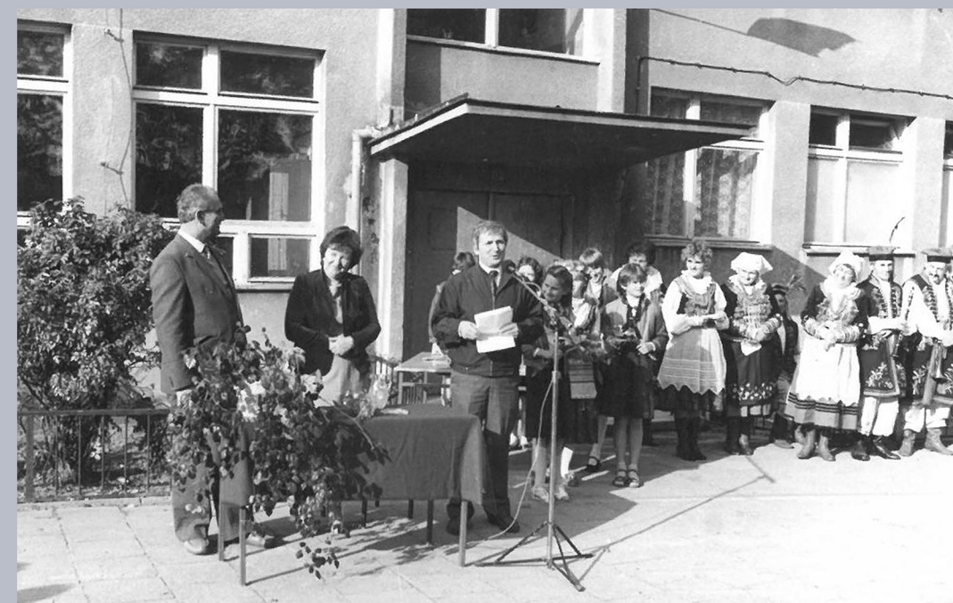
Uroczyste oddanie gazociągu w Starym Wiśniczu 1989r. Fot. arch. B. Dobrzańska.
