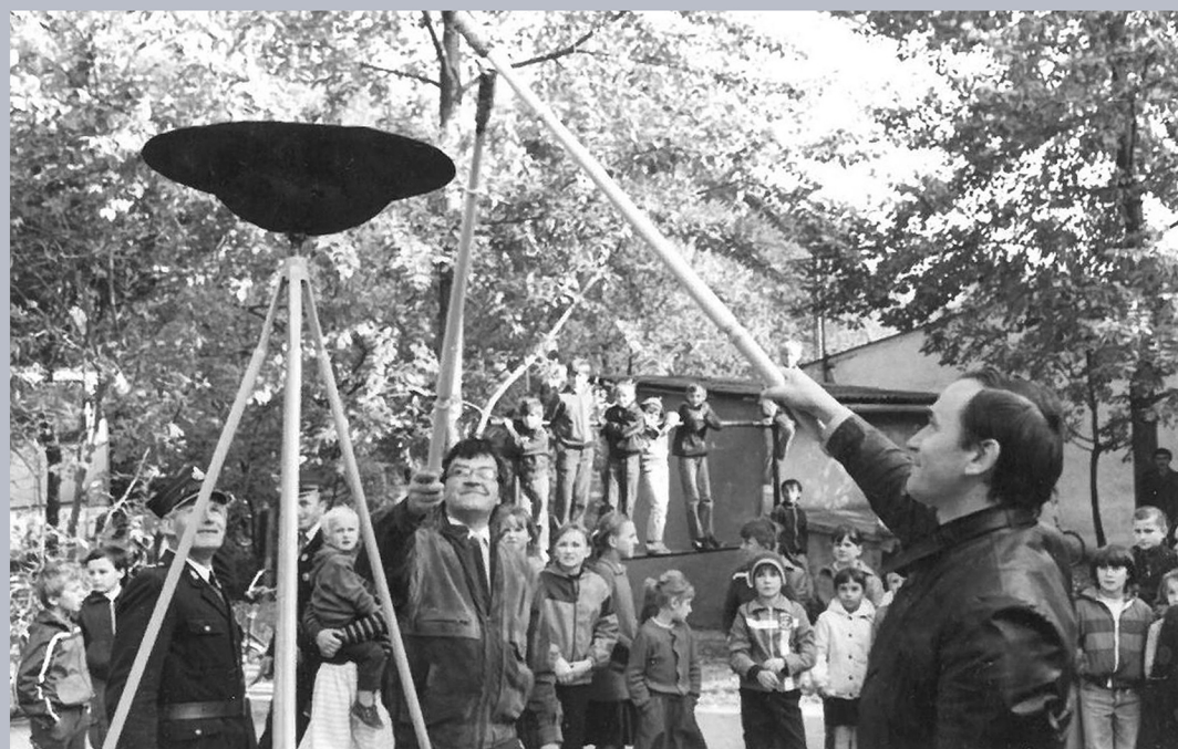
Zapalenie symbolicznego znicza podczas oddania gazociągu. 1989r. Fot. arch. B. Dobrzańska.
