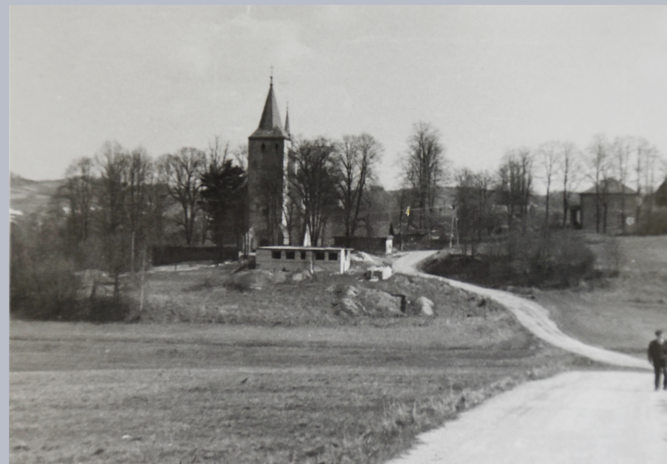
Pozpoczęcie budowy sali katechetycznej przy kościele parafialnym w Starym Wiśniczu. (Fot. 1983r.). Fot. arch. A. Bukowska.
