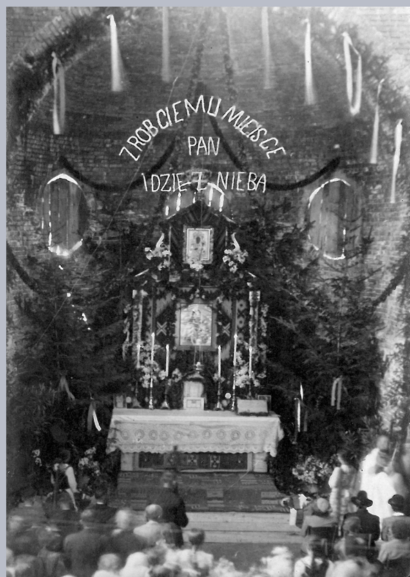
Kościół parafialny w Muchówce pomimo braku stolarki okiennej oraz wewnętrznych tynków został poświęcony i oddany do użytku z obawy przed przejęciem przez Niemców na magazyn. (Fot.1942r.). Fot. arch. W. Stary.
