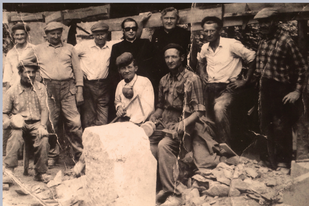
Mieszkańcy Królówki zaangażowani w budowę dzwonnicy i ogrodzenia wokół kościoła. Fot. arch. rodziny Guzaków.
