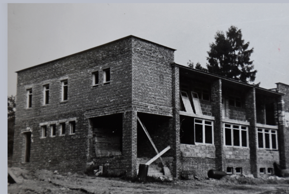
Budowa Ośrodka Zdrowia w Nowym Wiśniczu lata 60/70. XXw. Fot. arch. MOK.
