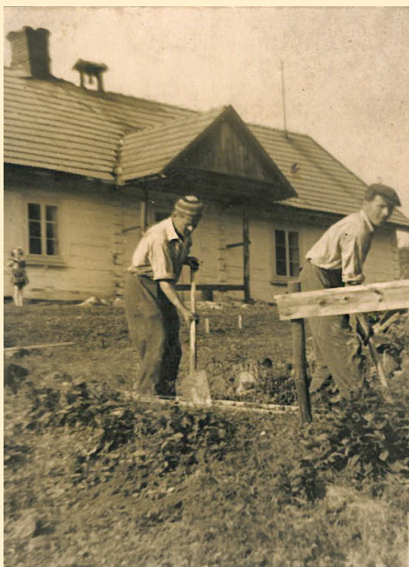
Kopanie fundamentów pod nowy budynek szkoły podstawowej.
