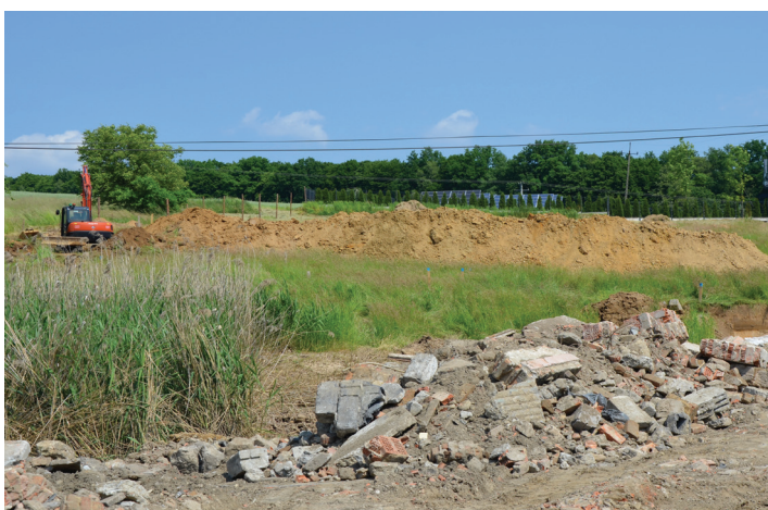
Prace ziemne przy budowie przedszkola i świetlicy w Olchawie.
