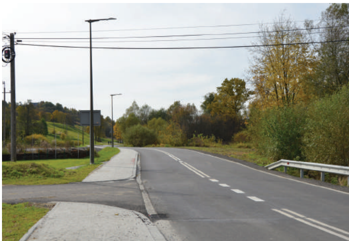
Przebudowa drogi w Królówce.
