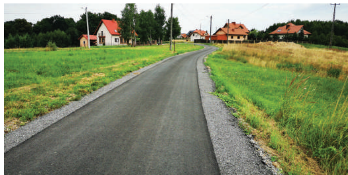
Zmodernizowany odcinek drogi.
