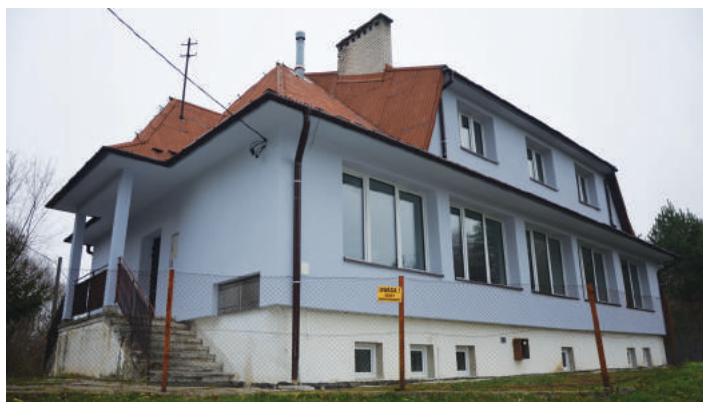
Nowa elewacja budynku dawnej szkoły w m. Łomna
