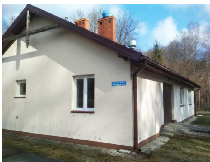
Budynek stacji uzdatniania wody w Leksandrowej
