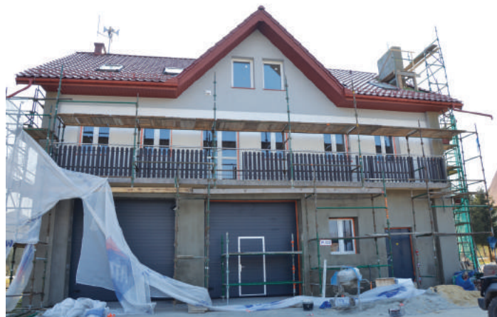
Remontowany budynek remizy OSP w Królówce
