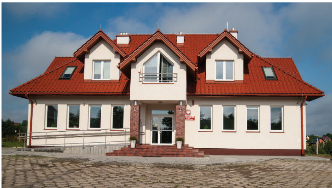
Nowy budynek biurowo - administracyjny PZD w Nowym Wiśniczu.
