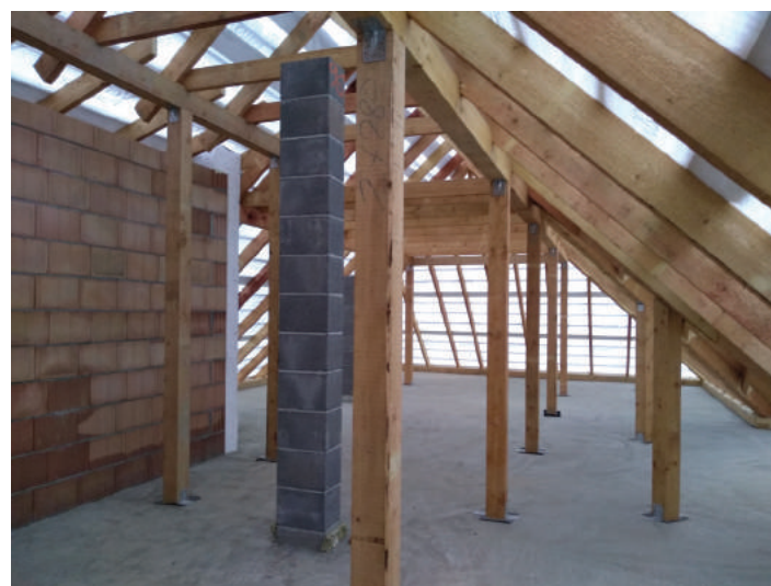
Budowa przedszkola w Olchawie
