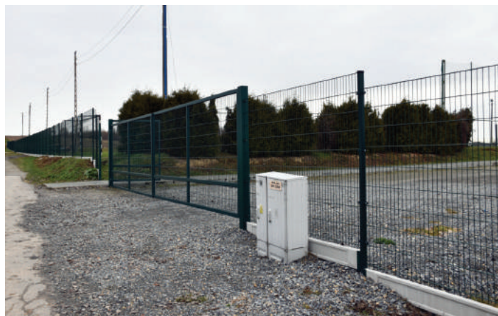
Ogrodzenie boiska w Muchówce
